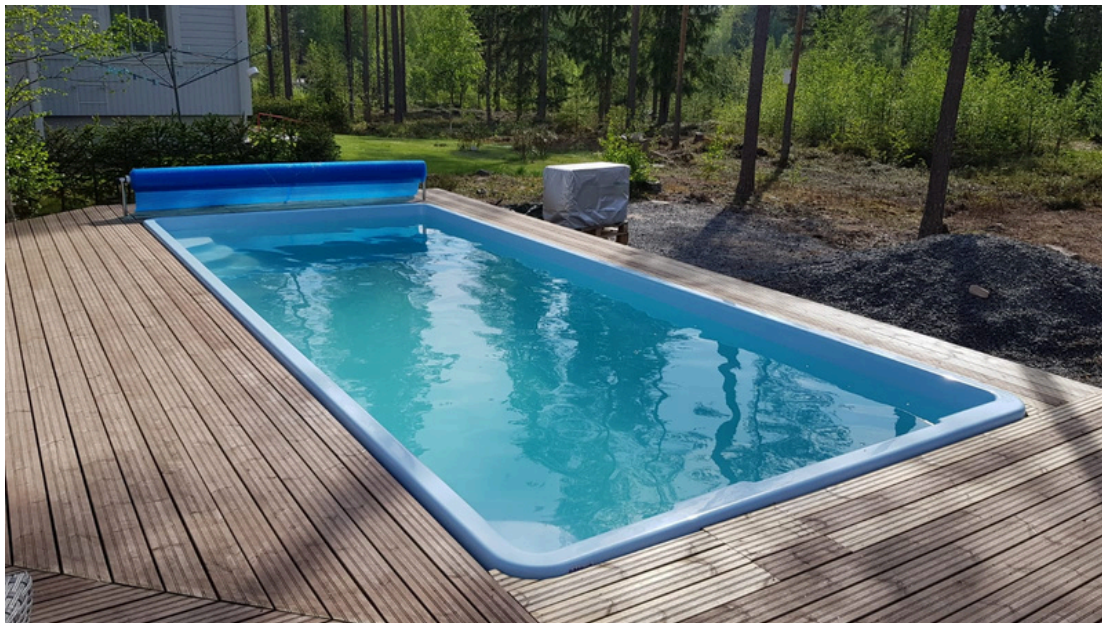
Terassirakenne yläreunaa vasten
