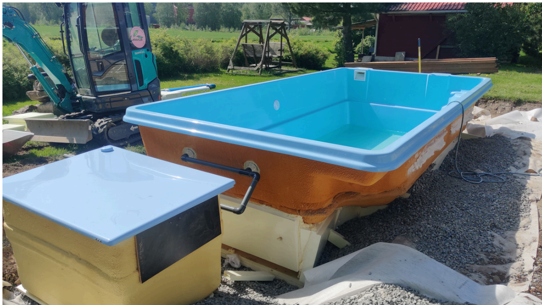
Teknisen tilan sähkökytkennät, kts 6.7
